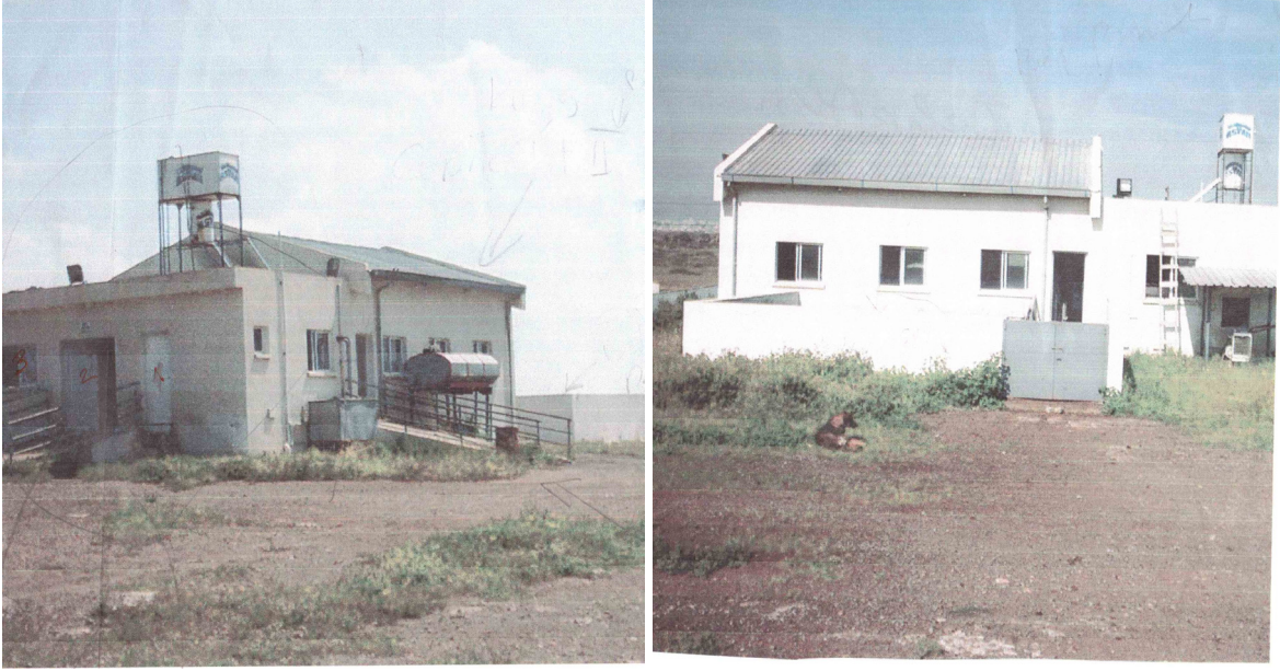
Fotoğraf 2. Yeni inşa edilen sağım tesisi (ERCAN DÜÇ)
